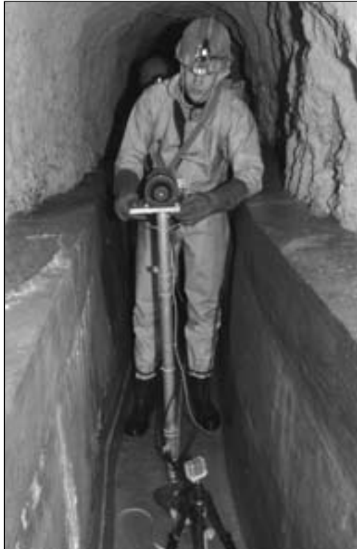
Le scanner 2D lors des mesures dans le tunnel de la Corbatière.
