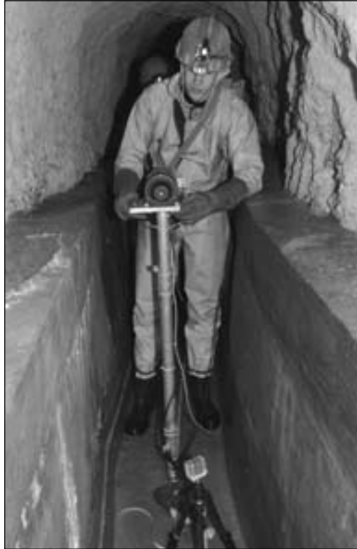
Der 2D-Scanner bei Messungen im Tunnel der Corbatière.
