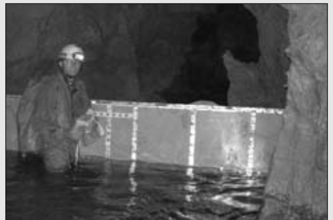
Einer der Ölabscheider, der am Lauf des unterirdischen Flusses in der Milandre-Höhle installiert wurde.
