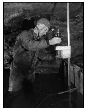
Unterirdischer Fluss der Milandrine: Unterhaltsarbeiten (einmal pro Monat) einer Messsonde von Kohlenwasserstoffen die auf der Höhle eines Olabscheiders montiert ist.
