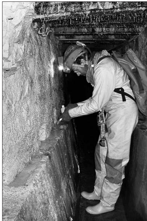
Arbeiten im Stollen von Jogne (NE): Wasserzufuhr für die Stadt La Chaux-de-Fonds. Der Bau eines neuen Tunnels soll den heutigen Stollen ersetzen. Für diese Untersuchungen wurde die KarstALEA-Methode angewendet.
