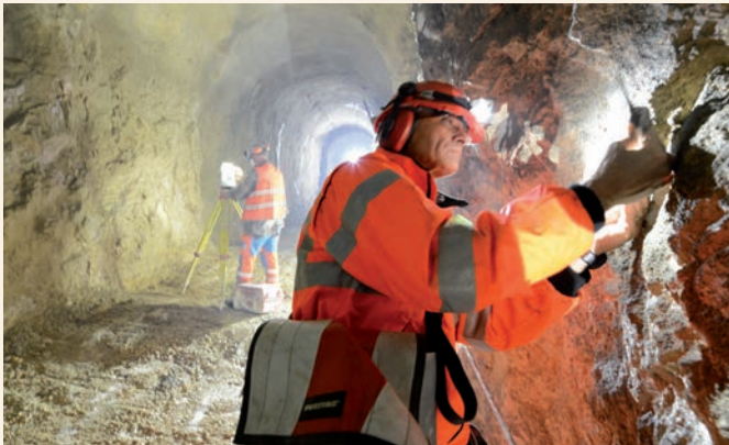
Geologische Begleitung beim Tunnelbau für die Wasserversorgung von La Chaux-de-Fonds.
