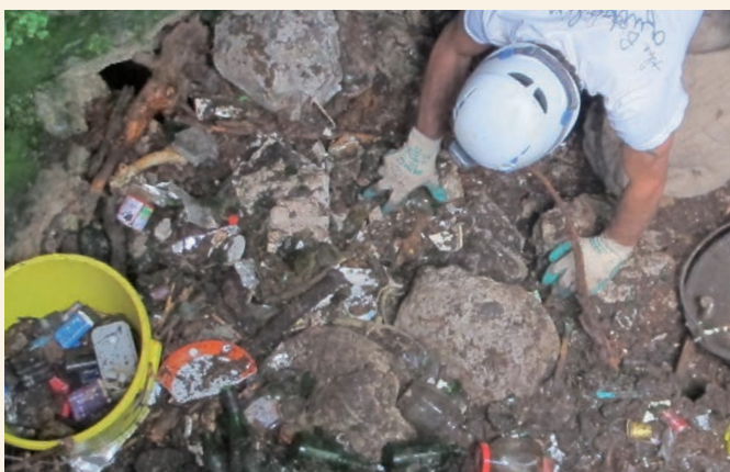
Zivildienstleistende haben, wie jedes Jahr, tüchtig bei Sanierungsarbeiten mitgewirkt.
