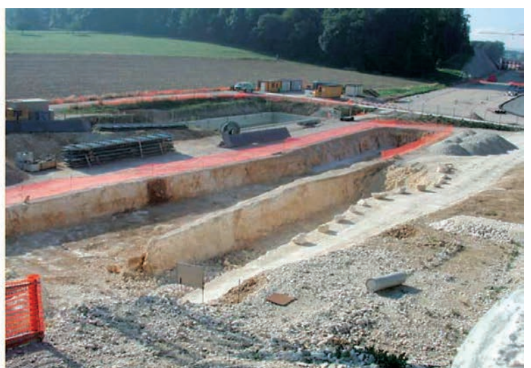
Wasserinfiltrationssystem zur Speisung der Tropfsteine, die sich unter der undurchlässigen Oberfläche der Autobahn befinden.
