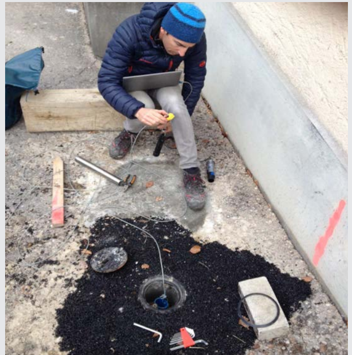
Auslesen des Wasserpegels, der Temperatur und der elektrischen Leitfähigkeit im Bohrloch R7 im Rahmen des Sanierungsprojektes des Wasserkraftwerks Furcil (NE).
