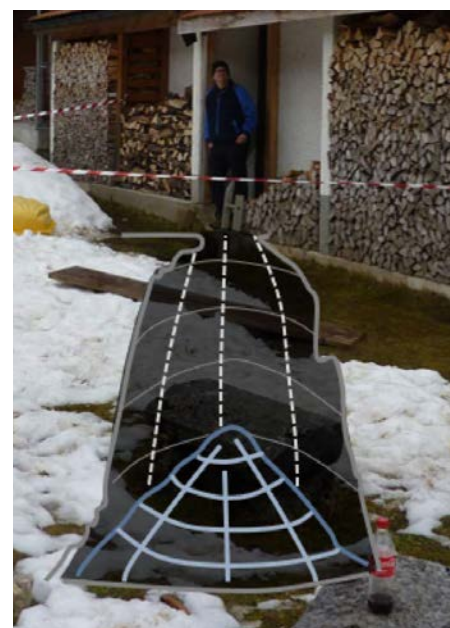
3 m tiefer Einsturz vor der Tür eines Hauses, verursacht durch das Versickern von Wasser vom Dach.
