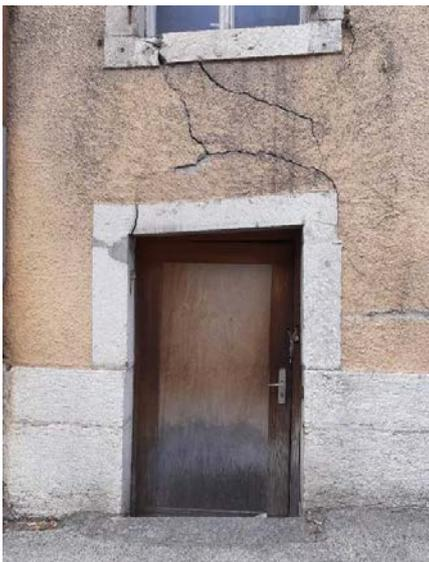
Die Innenstadt von Le Locle ist auf Torf gebaut, dessen Entwässerung zu Setzungen führt, die die Gebäude beschädigen.
