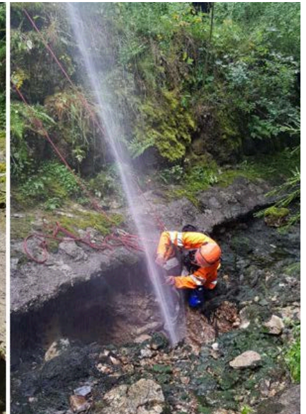
Hohlraum, der sich im Sommer 2023 unterhalb der Kläranlage von La Chaux-de-Fonds nach einem Hochwasserereignis geöffnet hat. Eine Wasserleitung war gebrochen.
