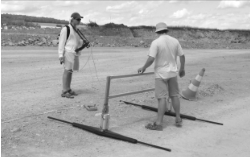
Elektromagnetische Messungen mit dem Georadar auf dem Autobahntrasse A16 in der Nähe von Puntrut.
