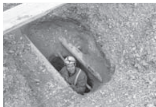
Bei Strassenbauarbeiten mitten in der Stadt La Chaux-de-Fonds wurde dieser Schacht entdeckt.
