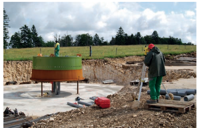
Bau des Fundaments einer Windkraftanlage auf einer Kalkschicht.
