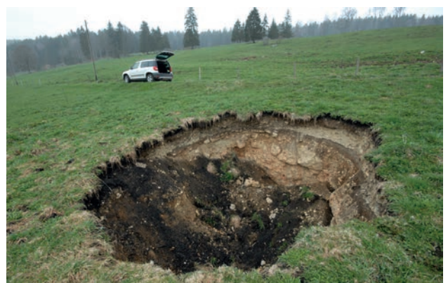
Beispiel einer unvermittelt aufgetretenen Sackung in einem Karstgebiet.
