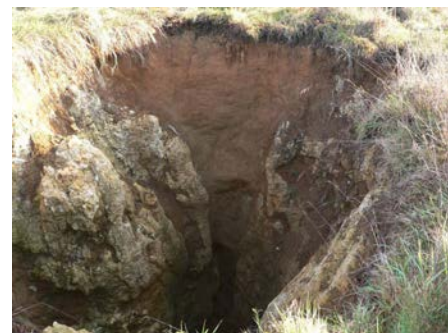
Injection d'un traceur dans une cavité récemment effondrée afin de mieux comprendre les écoulements jusqu'au captage de Röschenz (BL).
