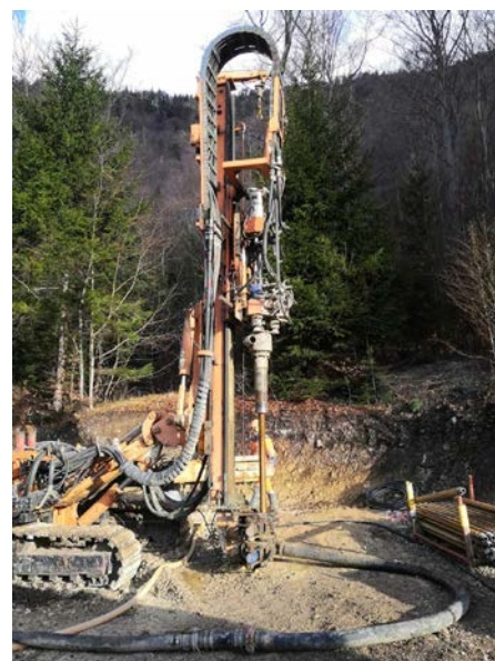
Exécution de forages dans la région du Furcil (NE) dans le cadre de l'évaluation d'un projet hydro-électrique.
